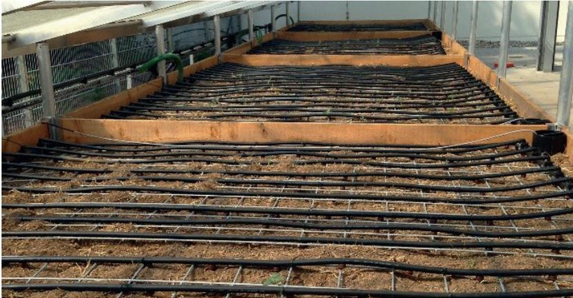
Abb. 1: Phytobac-System mit Berieselungseinheiten und Steuerung über Feuchtesensoren
