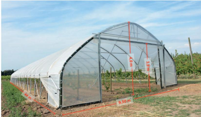
Abb. 1: Der Oppenheimer Steinobsttunnel mit Seiten- und Firstklappenlüftung. 3-reihiges Pflanzsystem.
